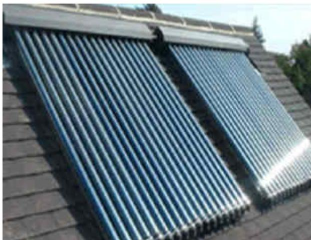
Солнечный коллектор — устройство, предназначенное для сбора тепловой энергии солнца, переносимой видимым светом и ближним инфракрасным излучением.
